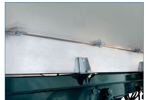
Boden verbinden mittels Klemmpratzen
